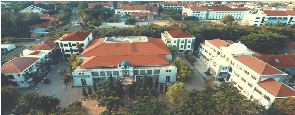
Gambar 1.1 Gedung SPs USK
